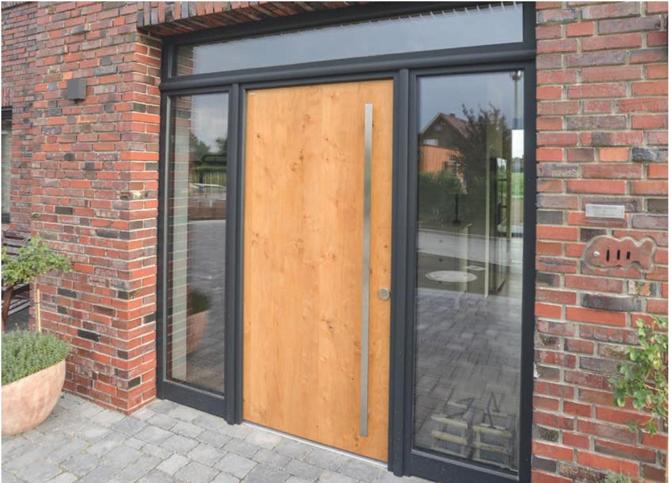
Eine schöne Konstruktion, entstanden aus einem Kundenwunsch: die Aluminiumrahmen auf den Koppungsprofilen von Seitenteilen und Oberlicht sind soft gerundet.
